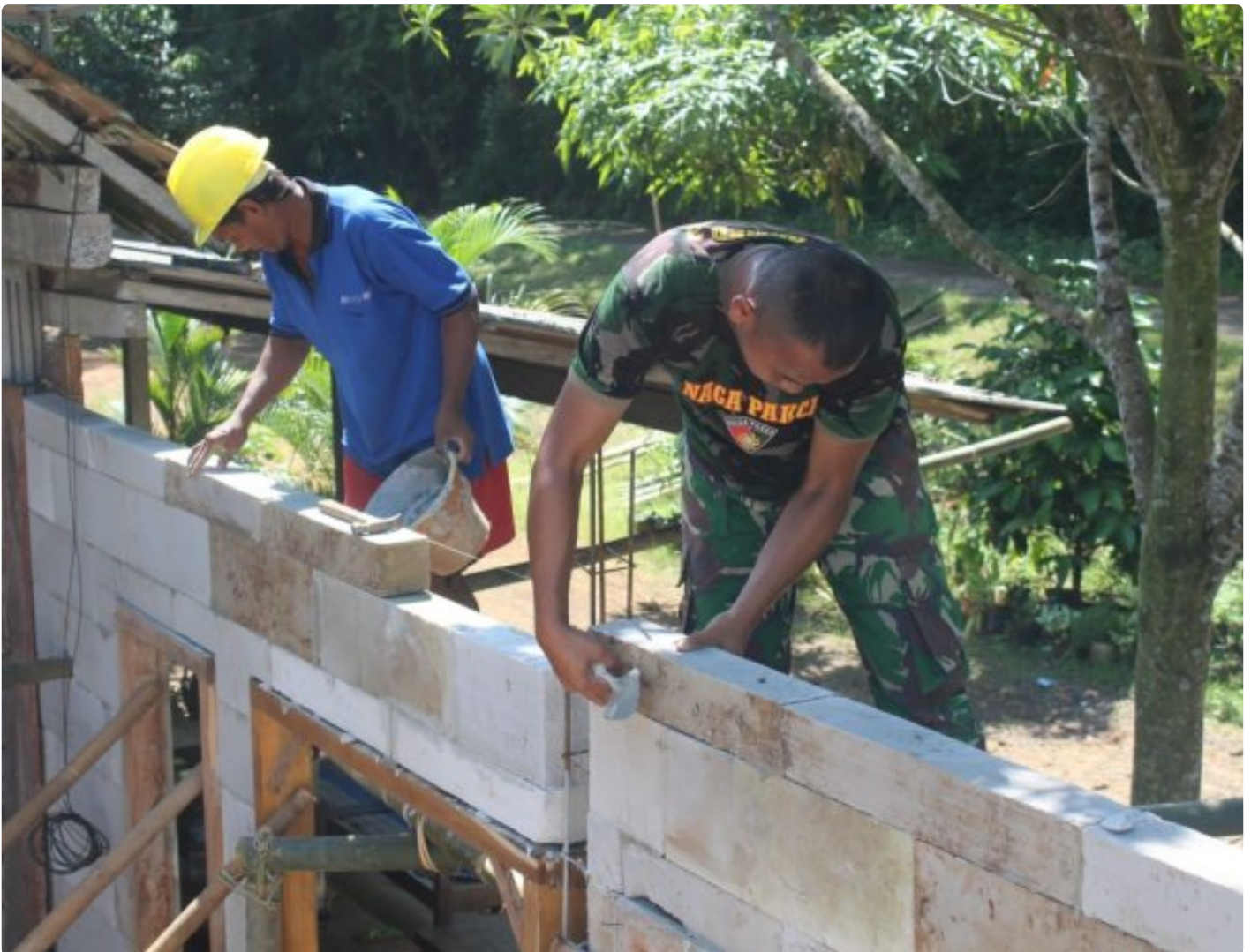
Pemasangan bata di rumah Bp Riyanto pembangunan RTHL
