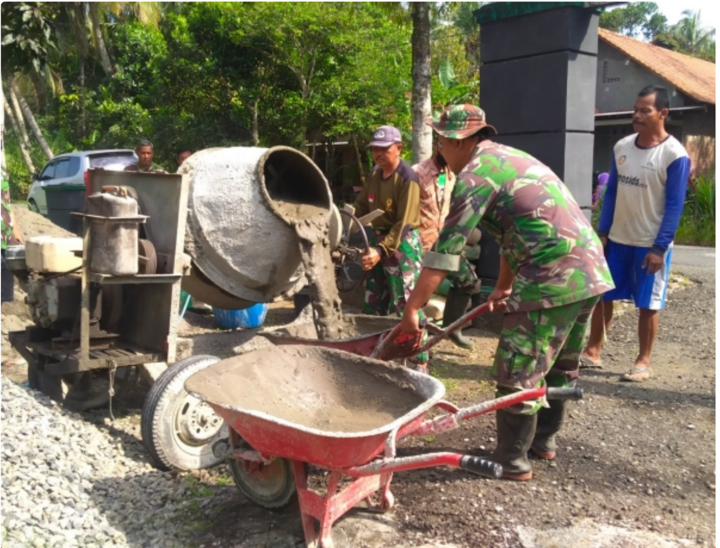
Anggota Posramil Bonorowo Bantu Warga Pengecoran Jalan
